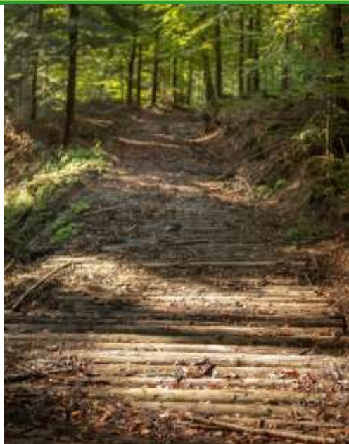
Fotografia 113. Dyłowanka na drodze leśnej w Nadleśnictwie Jeleśnia, fot. J. Smarczewski, 2021
