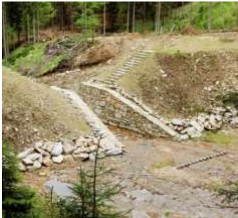
Fotografia 143. Widok na zaporę czołową dawnego zbiornika na cieku do spławu drewna w Nadleśnictwie Międzylesie, przerobionego na zbiornik przeciwpowodziowy (archiwum CKPŚ).
