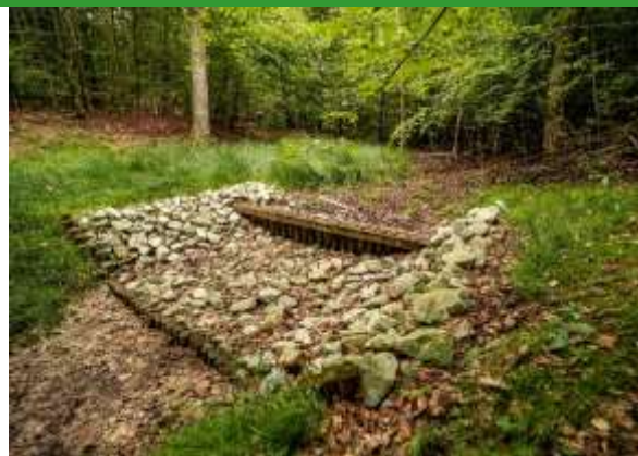
Fotografia 46. Próg drewniany z umocnieniem kamiennym w Nadleśnictwie Polanów, fot. J. Smarczewski, 2021.
