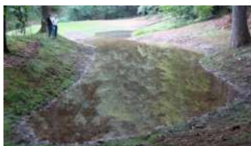
Fotografia 116., Fotografia 117., Fotografia 118. i Fotografia 119. Przykłady wykorzystania naturalnego ukształtowania terenu do realizacji zbiornika retencyjnego lub kałuży ekologicznej w Nadleśnictwie Piwniczna (archiwum CKPŚ).
