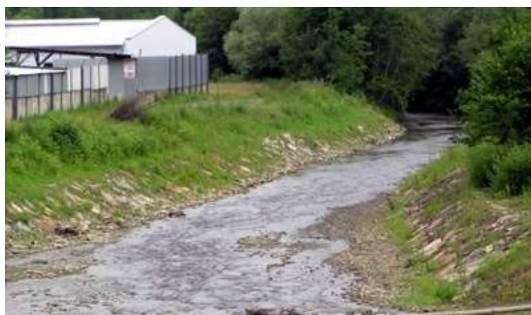
Fotografia 2. Koryto cieku umocnione ożywionym narzutem kamiennym.
