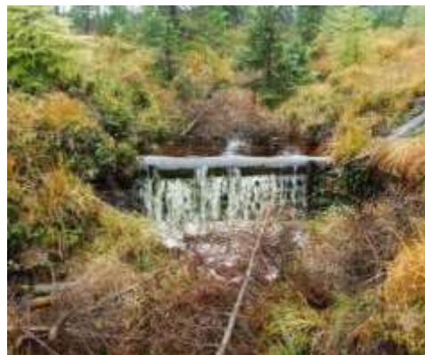
Fotografia 41. Próg drewniany na rowie odprowadzającym wodę z torfowisk po zboczu oraz rumosz drzewny wrzucany do rowu celem przyspieszenia zarostu w Nadleśnictwie Świeradów, 2010 (archiwum CKPŚ).
