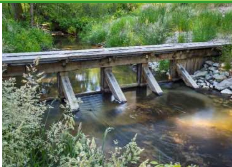
Fotografia 36. Jaz zastawkowy z kilkoma przęslami i szandorami w Nadleśnictwie Sieraków, fot. J. Smarczewski, 2023.
