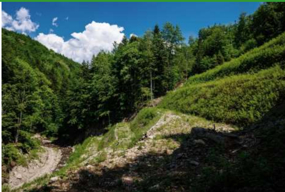
Fotografia 81. Kaszyca z pędami wierzby zabezpieczająca osuwisko pod drogą podcinane przez ciek. Nadleśnictwo Stuposiany (archiwum CKPŚ).
