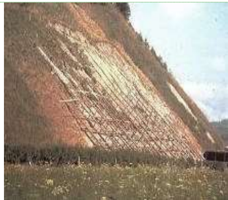
Fotografia 66 i Rysunek 67. Drewniane rusztowanie na skarpie wzmocnione nasadzeniami wierzbowymi [Begemann i Schiechl 1999].
