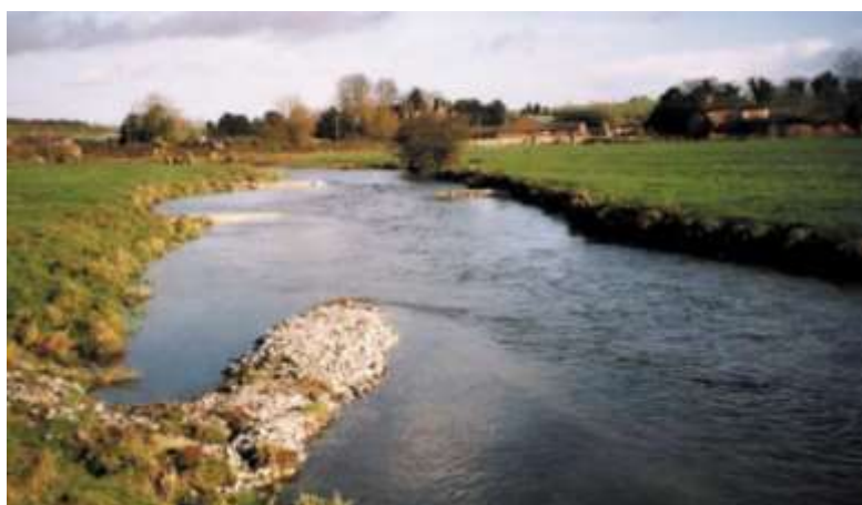
Fotografia 4. Ochrona brzegów rzeki wyłącznie przez wykonanie głowic ostróg [Krukowski, 2006].
