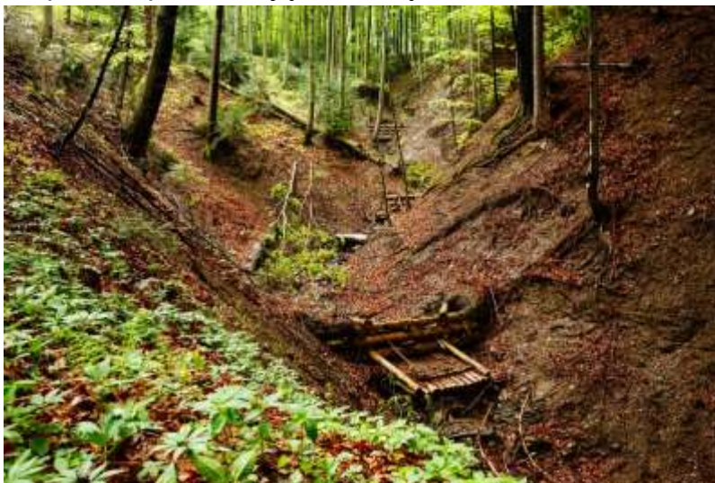
Fotografia 155. Niewielkie zapory przeciwrumowskowe rozłożone w wyerodowanym wąwozie na cieku okresowym. W Nadleśnictwie Limanowa (archiwum CKPŚ).
