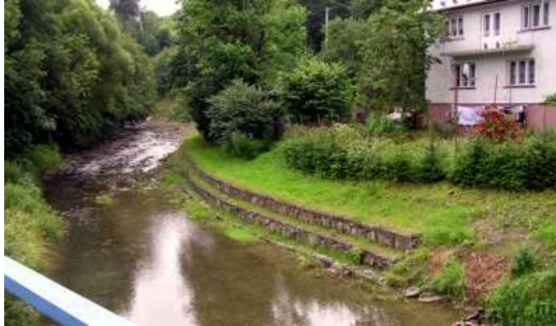
Fotografia 3. Zabezpieczenie brzegu gabionami w celu ochrony zabudowy.
