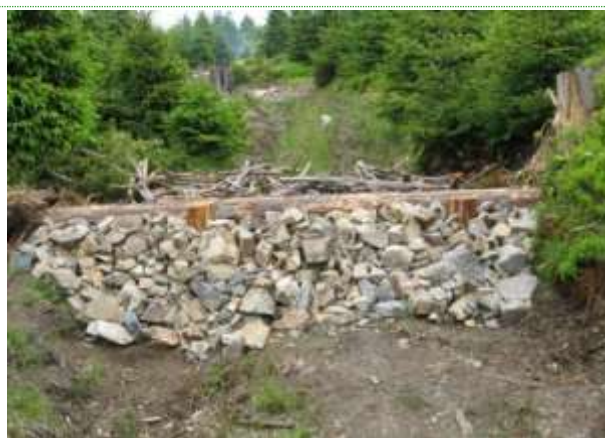
Fotografia 102. Przegroda drewniana wypełniona gałęziówką ubezpieczona narzutem kamiennym w Nadleśnictwie Łądek Zdrój (archiwum CKPŚ).
