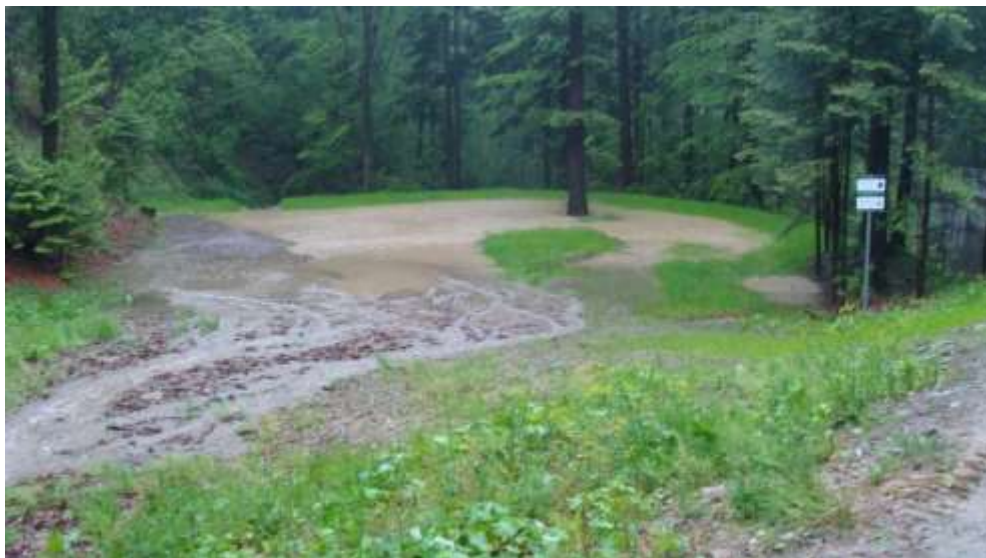
Fotografia 122. Zbiornik retencyjny w Nadleśnictwie Piwniczna na spływ powierzchniowy zaraz po wybudowaniu, dodatkowo zasilany wodą spływającą z leśnej drogi (archiwum CKPŚ).
