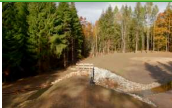
Fotografia 27. i Fotografia 28. Suchy zbiornik w Nadleśnictwie Śnieżka z przelewem szczelinowym [ https://www.youtube.com/watch?v=0KC01khUkeY ].
