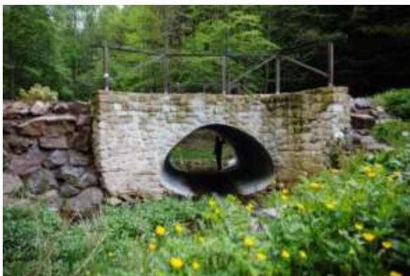
Fotografia 153. Ażurowa barierka na szczycie przepustu (archiwum CKPŚ).
