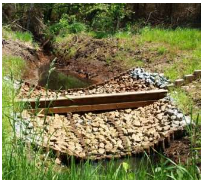
Fotografia 38. Dobrze ubezpieczony próg z pojedynczej ścianki szczelnej, fot. Z. Filipek (archiwum CKPŚ).
