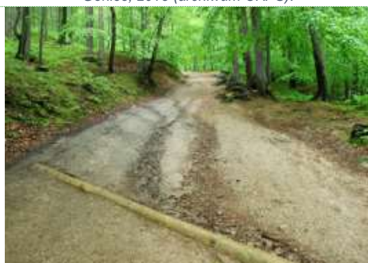
Fotografia 108. Wodospust z pojedynczego okrąglaka (archiwum CKPŚ).
