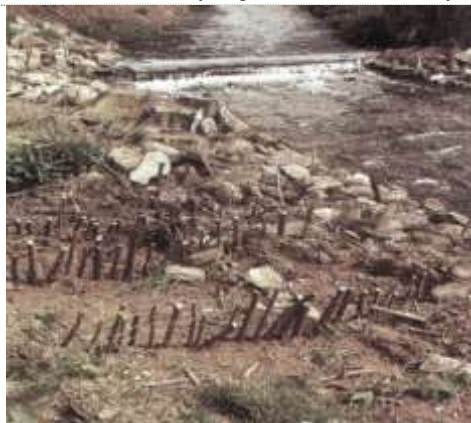
Fotografia 70. Płotek ze zrzesów wierzbowych tuż po wykonaniu [Begemann i Schiechl 1999].
