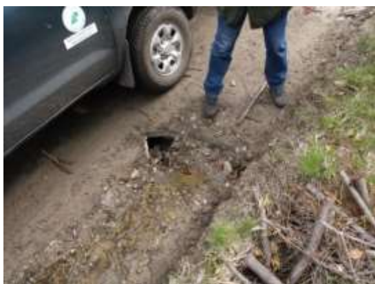
Fotografia 53. i Fotografia 54. Przypadkowo odkryty betonowy zbieracz sieci drenarskiej pod drogą na zdrenowanym w okresie przedwojennym zboczu, obecnie miejscowo porośniętym torfowcem (dawne uproduktywnienia terenu) w Nadleśnictwie Wałbrzych (archiwum CKPŚ).
