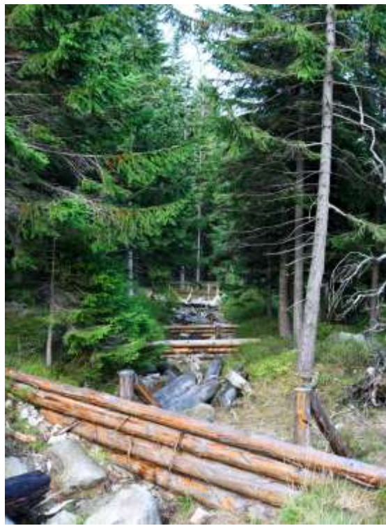
Fotografia 8. Zabudowa przeciwozyjna w trasie spływów powierzchniowych (archiwum CKPŚ)
